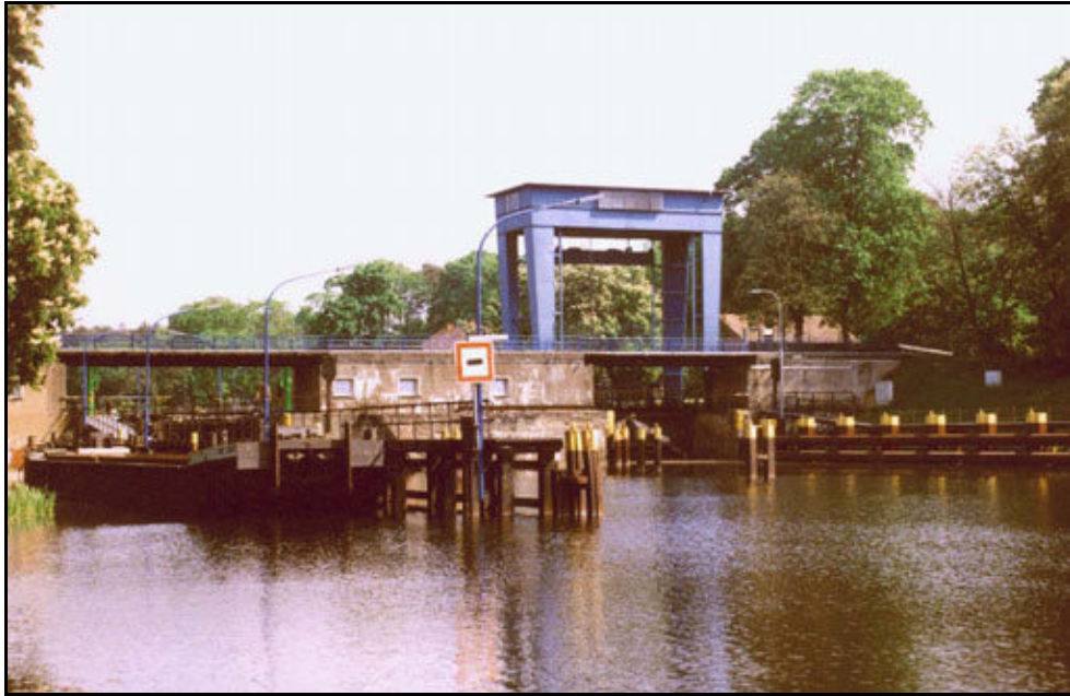
Blick von Westen auf die Schleuse, 2002
