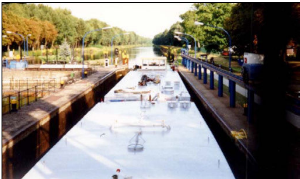
Blick in die südliche Schleusenammer 1998
