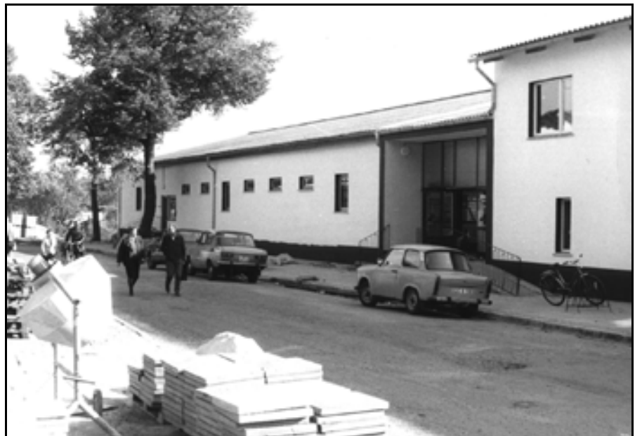
Die neue Halle 1988
