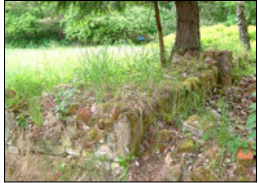
Fundamentreste der Försterei „Breitegestell“
