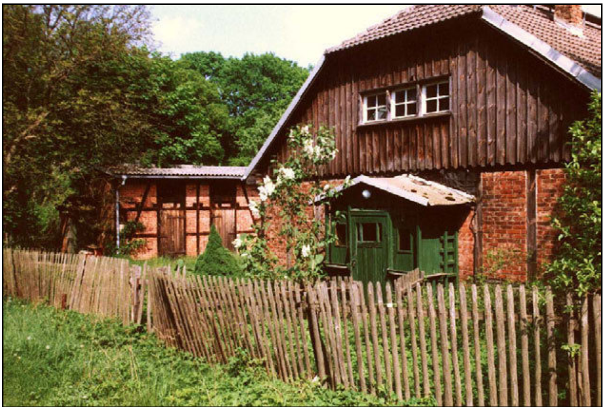
Von 1920-1937 war in einem Raum Schulunterricht. Bis 1990 wohnten hier mehrere Familien.
