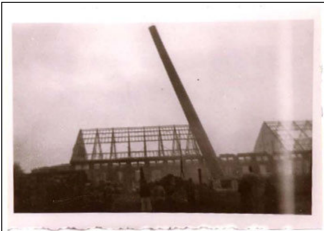
Bei der Umlegung des Schornsteines, am 11.4.1937, finden sich viele Schaulustige ein. Beim Einsturz bricht der Schlot halb durch.
