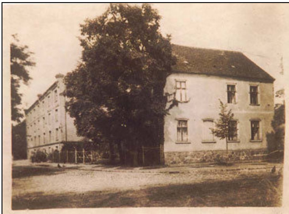
Das Wohnhaus Meyer entstand ab 1905 durch Umbau der alten Schule, vermutlich kam die obere Etage dazu (andere Fensterform) und die Wände wurden verputzt.
