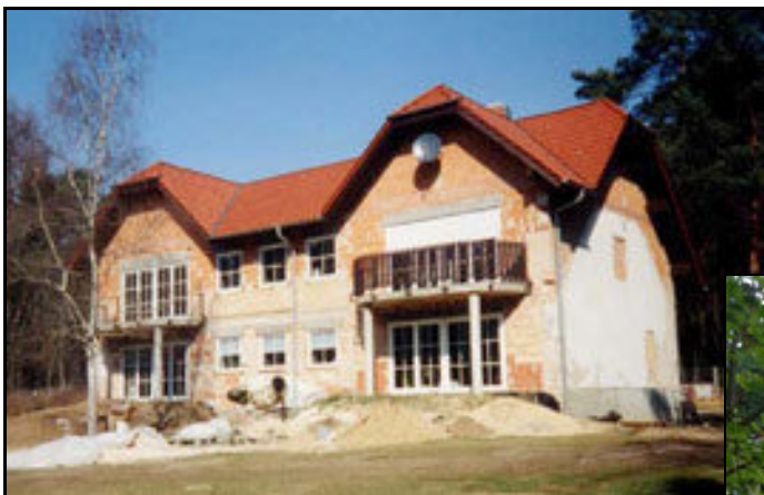
Während des Umbaus kann man am Giebel noch das Profil des alten Hauses erkennen.
